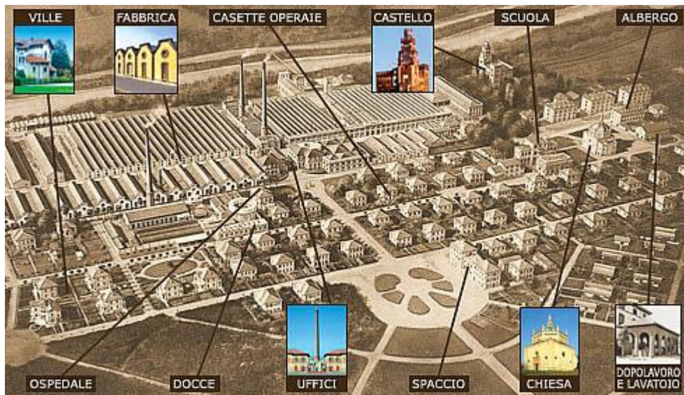
Figura 2.2: Villaggio operaio Crespi d'Adda
